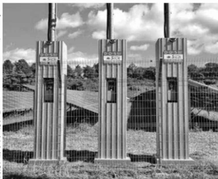
▶ダイナミックソーラの低圧太陽光発電所用ケーブル盗難対策「DDS」
